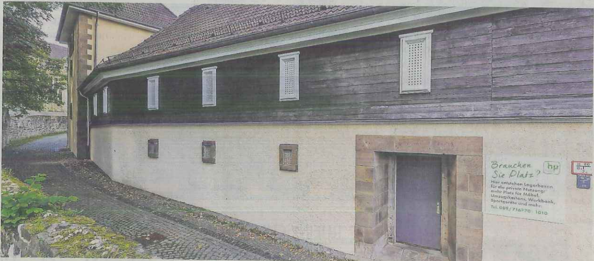
„Brauchen Sie Platz?“ steht auf dem Schild neben der Eingangstür im ehemaligen Bunker an der Wallstraße. Hinter dicken Mauern verbergen sich Lagerräume, die vermietet werden.
